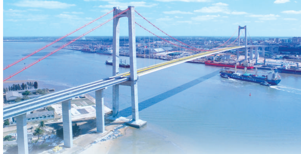
▶当地工人在对莫桑比克马普托大桥进行日常维护。 本报记者 邹松摄 ▼莫桑比克马普托大桥全景。 陈豪举摄
